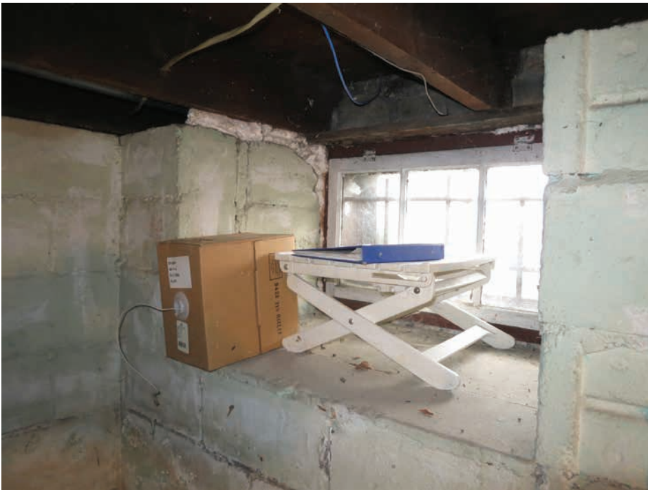
Foundation wall (ERA, 2022).
